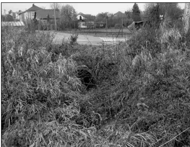
Polančice v současnosti vytéká z betonové roury pod místní komunikací (Foto Radim Jarošek).
