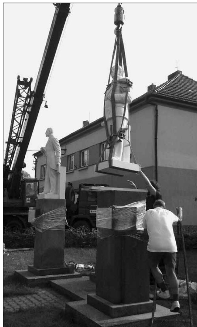
Instalace sochy za pomoci jeřábu. Socha je vysoká 196 cm a má hmotnost 3 tuny (Foto RNDr. Mojmír Krejčíček).
