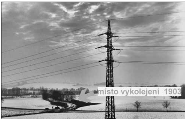
Pohled na trať u km 3,5 – místo vykolejení vlaku. Trať byla původně dlouhá 8,125 km, byla upravována, dnes měří 8 km (Foto autor, 11. 2. 2017).
