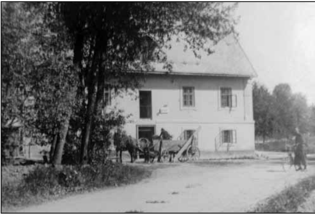
Momentka zachycující mlýn někdy kolem 2. světové války. Nad vchodem se nachází dveřím podobný otvor, z něhož se spouštěly pytle do vozů, vedle něj je pak patrný firemní štít.
