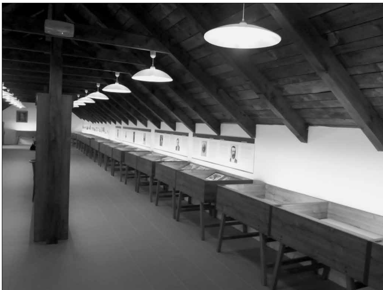
Interiér výstavního prostoru po provedené opravě.
