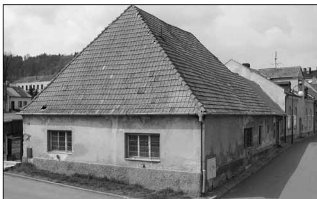
Stav Katovny před celkovou opravou (všechny foto Muzejní spolek Rolleder o.p.s.).
