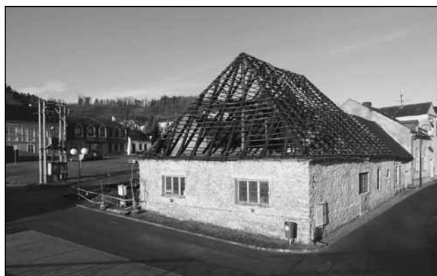
Záběr z rekonstrukce střechy objektu.
