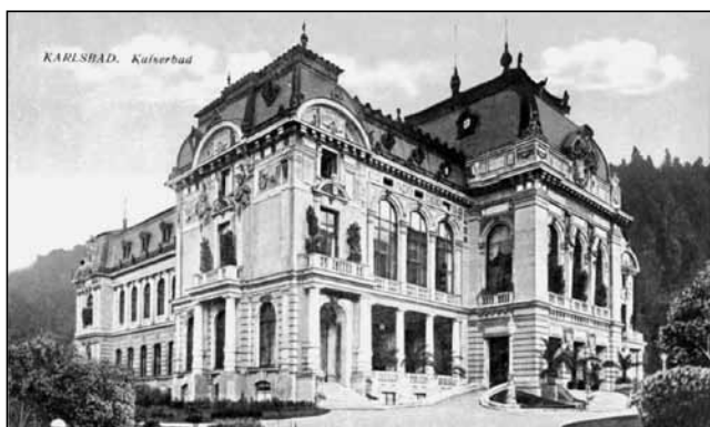
Karlovy Vary, Císařské lázně (horní foto z r. 2016, spodní z přelomu 19. a 20. století). Neorenesanční patrová lázeňská budova. Spolupráce Emila Zimmermanna na výzdobě budovy, pravděpodobně s firmou Antona Detoma nebo firmou Matschek & Schrödl, www.karlovyvary.cz
