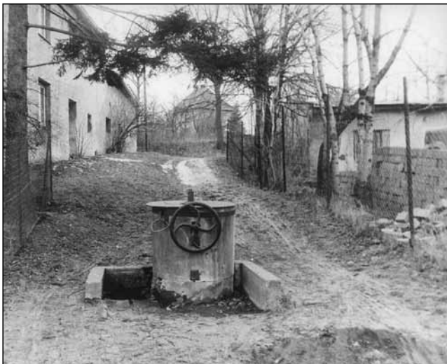
Pro veřejný odběr vody sloužila studna U Lípy (Lipový pramen), betonová skruž s ručním čerpáním otočným kovovým kolem (Foto Radim Jarošek, r. 1992).
