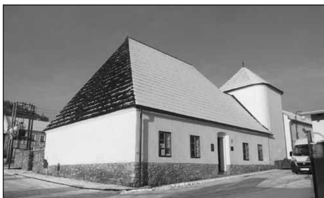
Katovna po opravě.
